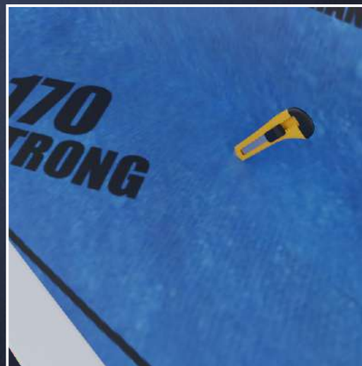
Wycinanie w membranie otworu pod spust rynny.
