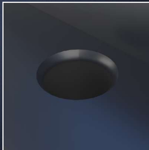
Otwór powinien być około 1 cm mniejszy od wycięcia w płycie OSB - tak aby można było zaklepać obróbkę do środka gilzy.
