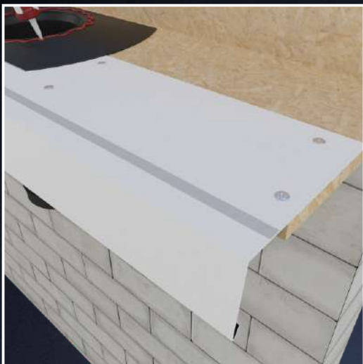
Względ obróbki parapetu przyklejamy taśmę dwustronną do membrany.
