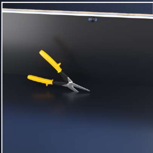
Wycinanie w obróbkę okrągłego otworu pod spust rynny.
